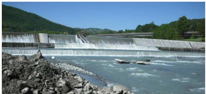
La figura seguente mostra la scala di risalita dell'ittiofauna realizzata a lato dell'impianto in progetto, si tratta di una rampa in pietrame che permette la risalita dei pesci.
